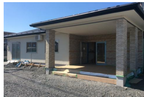
【建設中の障がい者施設】
